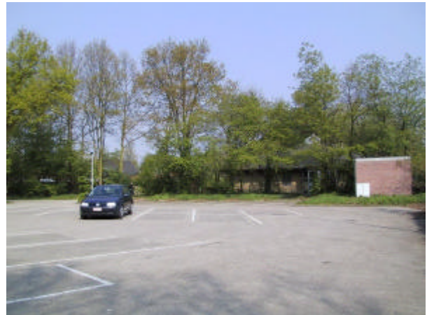
Figuur 9: foto's gebouw en parking KFC St.-Martinus
